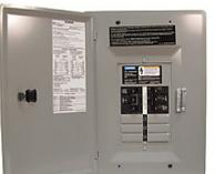
**4** Branchez l'appareil à la source d'alimentation c.a. et aux pompes de zone à l'aide de câbles appropriés pour une puissance de 120 VCA. Branchez les autres bornes aux autres appareils à l'aide de câbles appropriés. Veillez à enfiler le câble dans les entrées défonçables et à utiliser des serre-câbles pour fixer le câblage à l'appareil.
